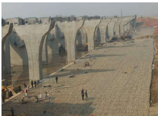
下游海漫施工部位雷诺护垫防护
