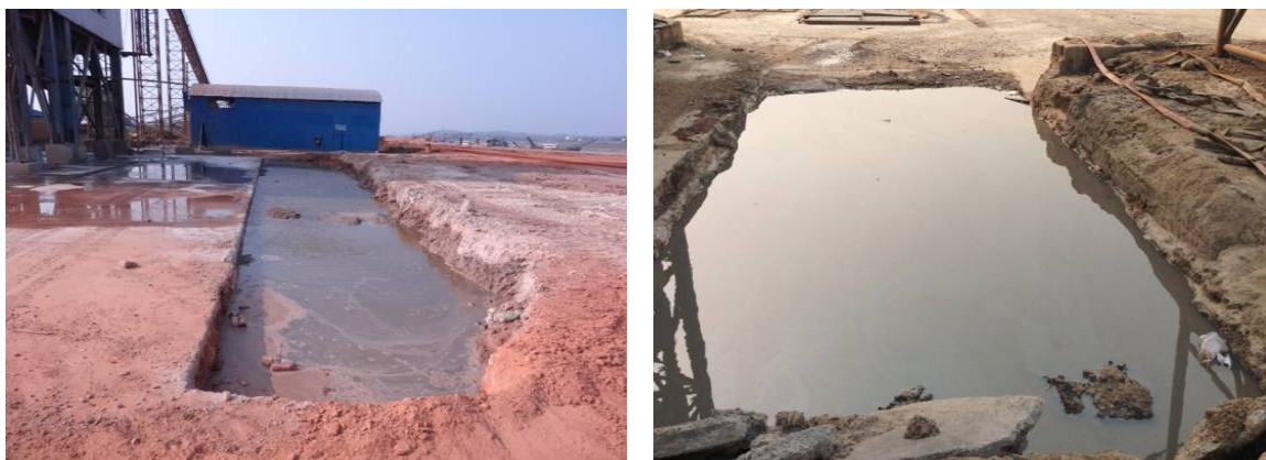
砂石系统沉淀池
