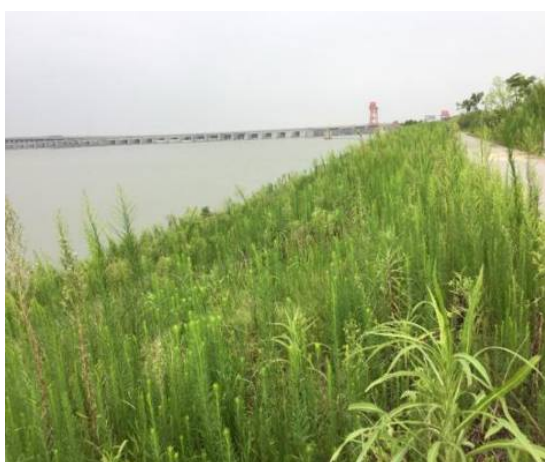
左岸进场道路边坡现状
