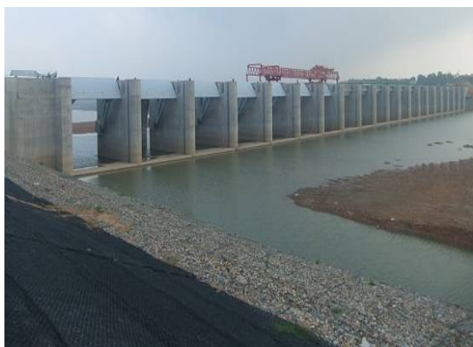
土工布+雷诺石笼敷设
