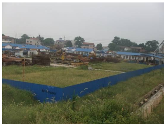
施工生产区植物措施
