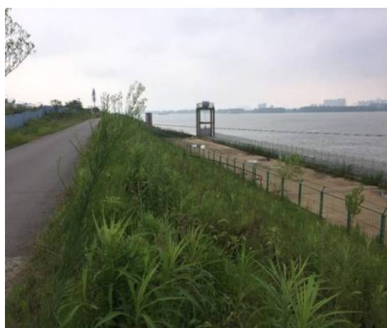
左岸进场道路现状
