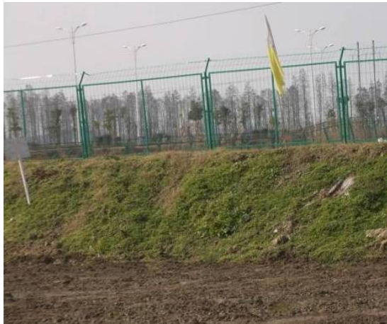
临时堆土植草防护
