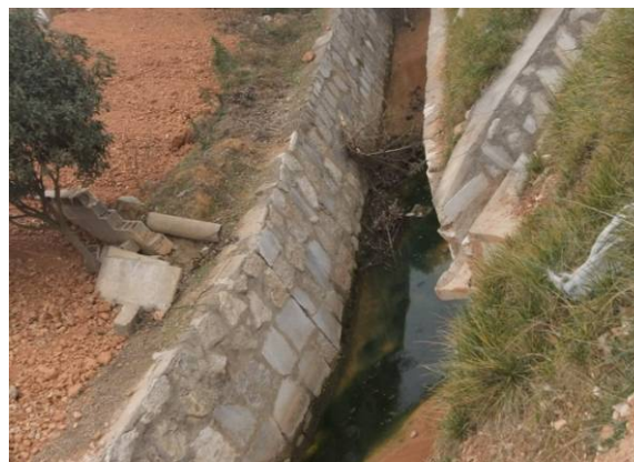
右岸进场道路排水沟
