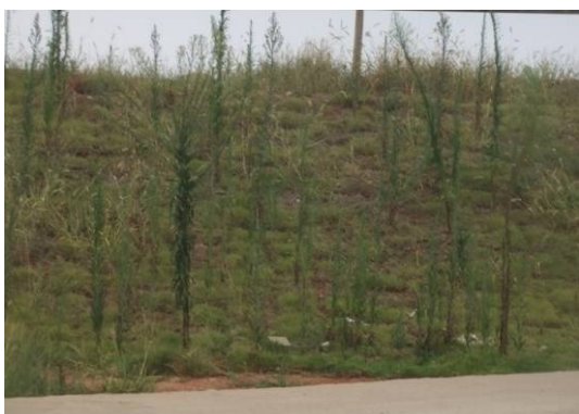
临时堆土区植草防护
