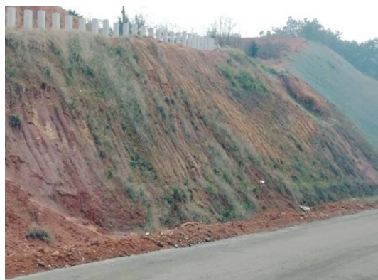
右岸进场道路植草护坡
