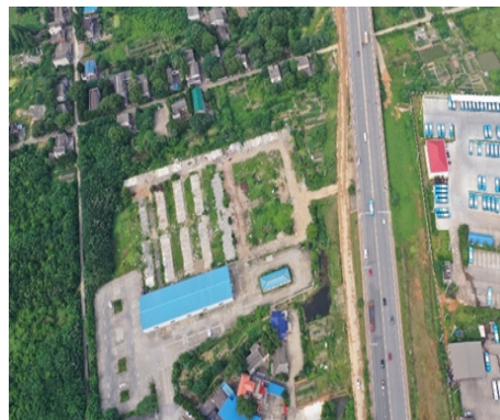
左岸道路施工营地现状
