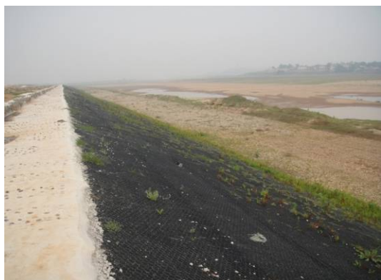
蔡家洲加筋麦克护坡
