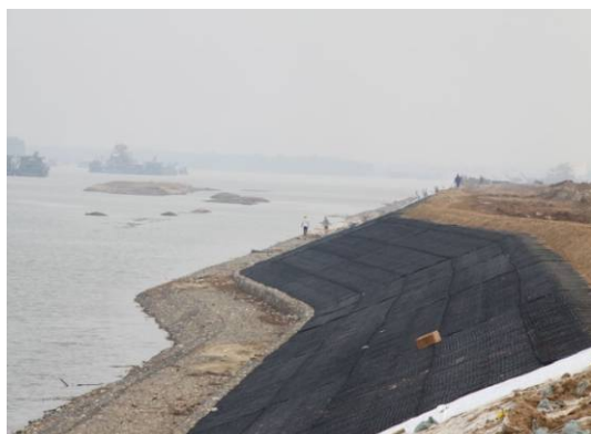
蔡家洲加筋麦克护坡
