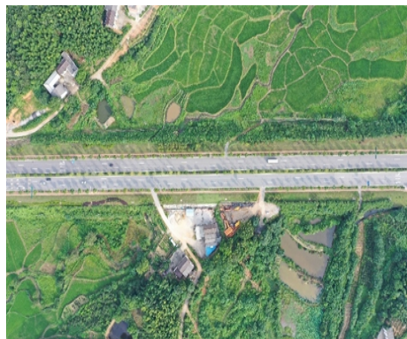
右岸进场道路现状
