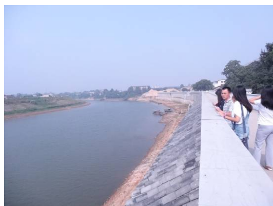
浏阳河榔梨段防洪墙
