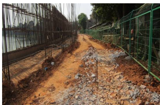
管道敷设后回填
