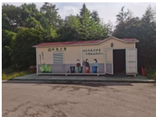
枢纽管理区垃圾收集处
