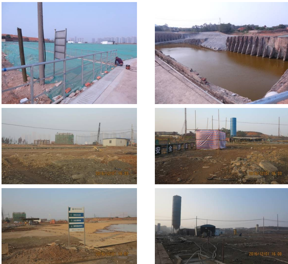
图 4.2.2-5 铬盐厂土壤修复项目施工现场
