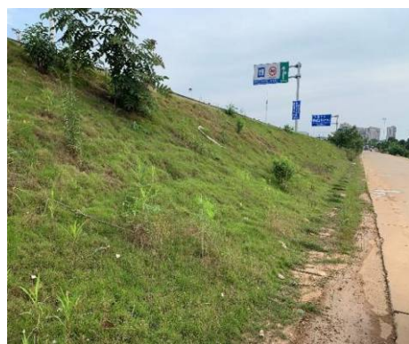
左岸进场道路边坡现状
