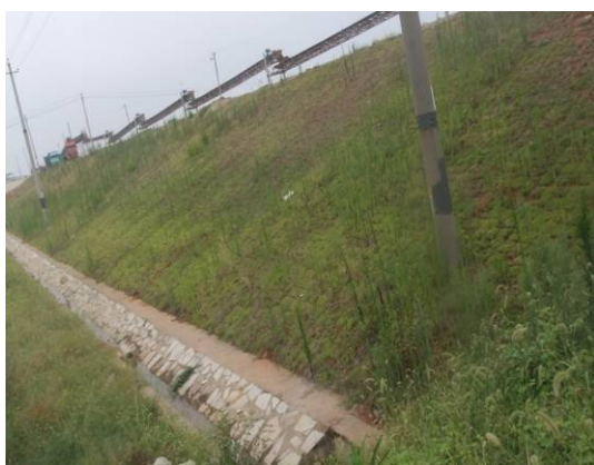
新建防洪堤排水沟
