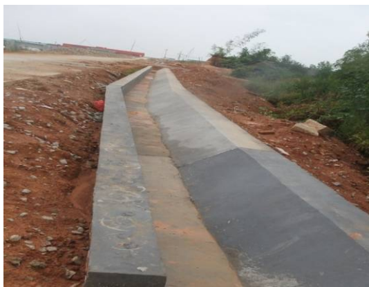
进场道路排水沟
